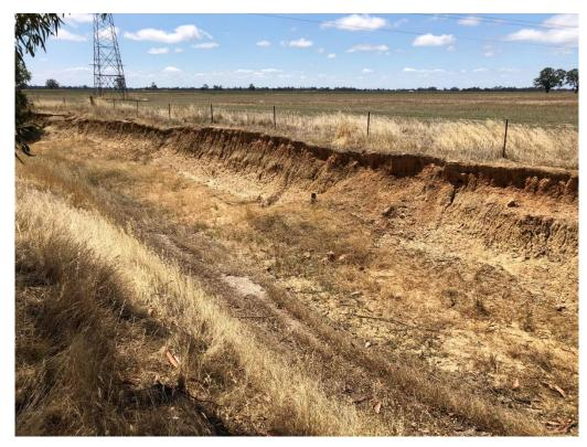
FIGURE 5-20 ISOLATED BANK EROSION DOWNSTREAM OF THE DUNMUNKLE CREEK – MAIN CENTRAL CHANNEL CONFLUENCE.
